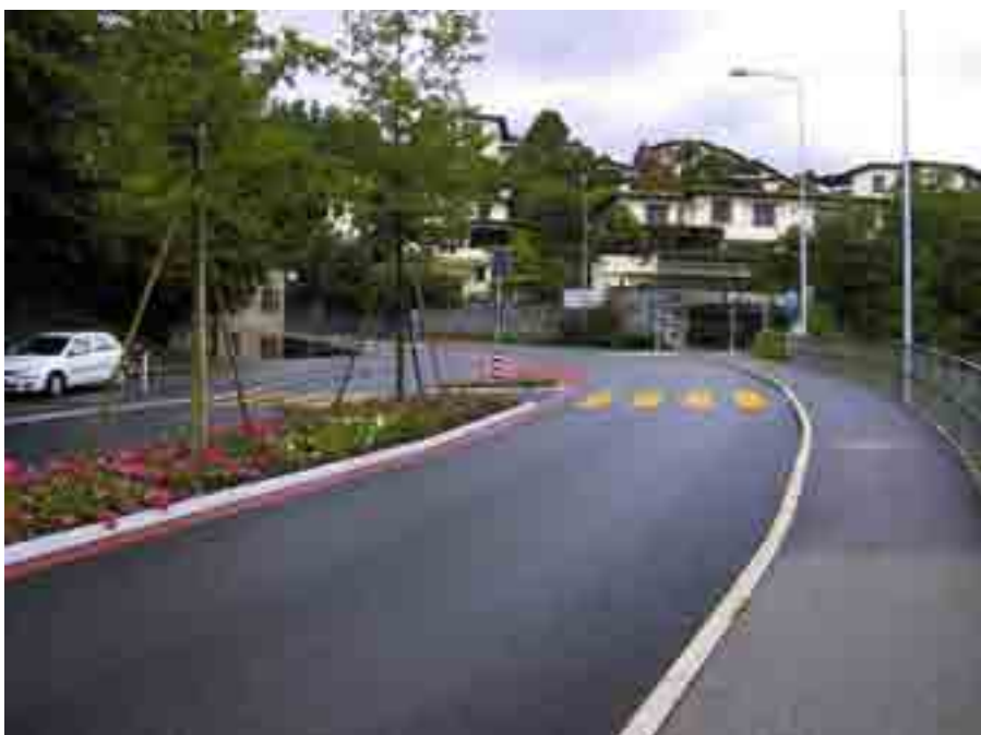
Canobbio, fascia centrale attrezzata, isola spartitraffico (arcch. L. Custer e B. Allenbach)
